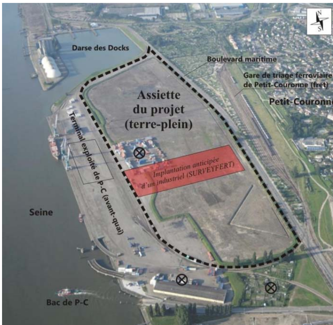
Figure n° 2 : Photographie aérienne du site (source : dossier). Depuis la date de la photographie, les éléments marqués d'une croix ont été supprimés, et les entreprises Surveyfert, GDE et Beuzelin se sont implantées respectivement dans le rectangle rouge (hangar de stockage), dans le rectangle parallèle au quai (enclos de stockage de déchets métalliques) et, à son nord, sous l'inscription « terminal » (silo à grains).
